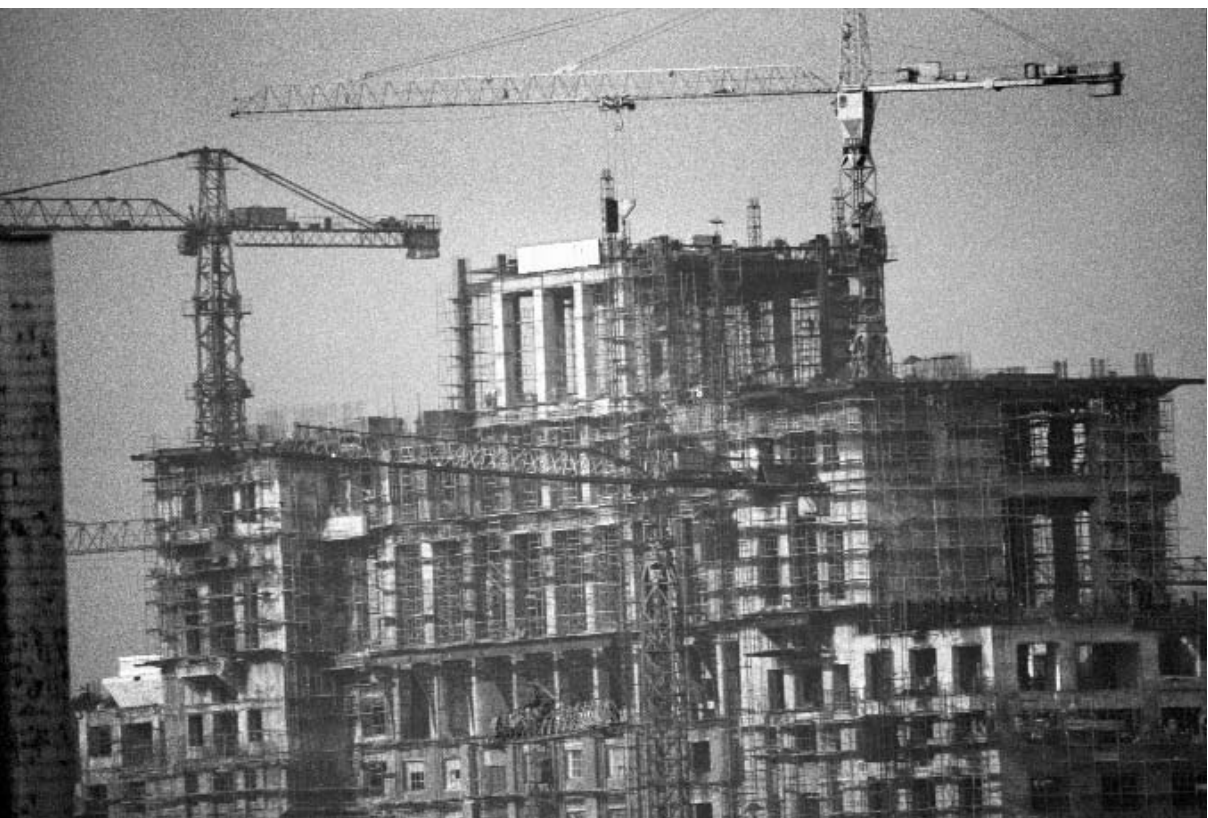
Șantierul Casei Poporului, văzut din imobilul Electrolux de pe Calea Victoriei. Mai 1987
